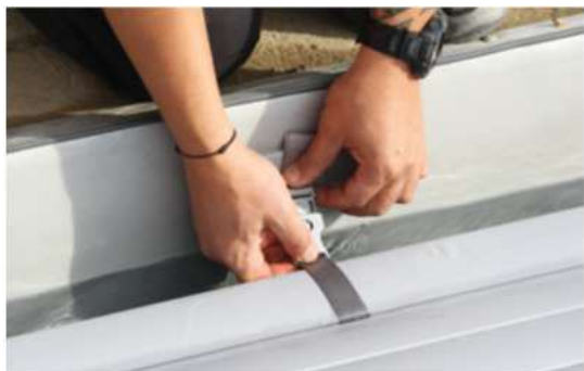
Ohne Autofix, manuelle Verriegelung der Sicherheitsclips
